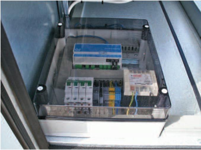
Das Gerät kann über einen PC oder Laptop bedient werden. Schließen Sie Ihren PC oder Laptop mit einem LAN-Kabel an den Master im Anschlusskasten an.
