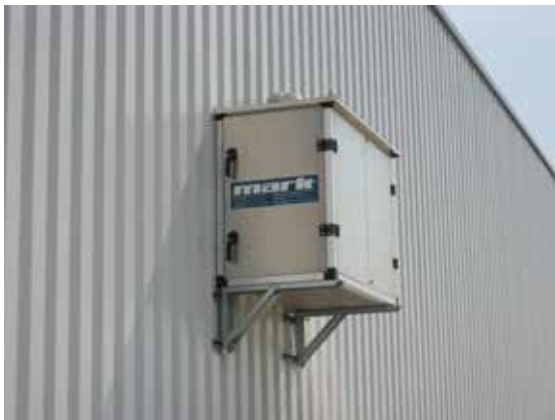
Optional: Brenner an der Außenwand
